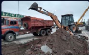
Escavação de subleito
