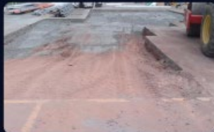
Nivelamento e compactação de base
