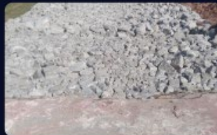
Nivelamento e compactação de sub-base
