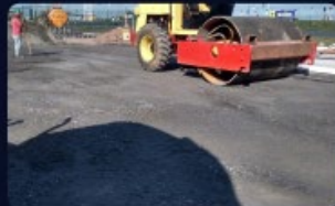
Compactação da base asfáltica
