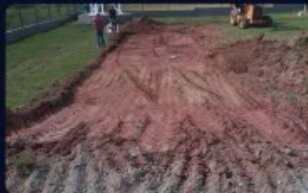
Escavação de subleito
